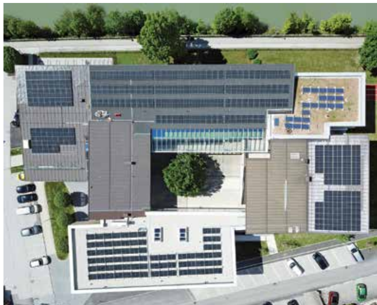
Die e5-Gemeinde setzt schon lange auf nachhaltige Stromproduktion auf den Dächern von gemeindeeigenen Objekten, wie hier auf dem Dach der Volksschule an der Salzach. Foto: M. Schnell
